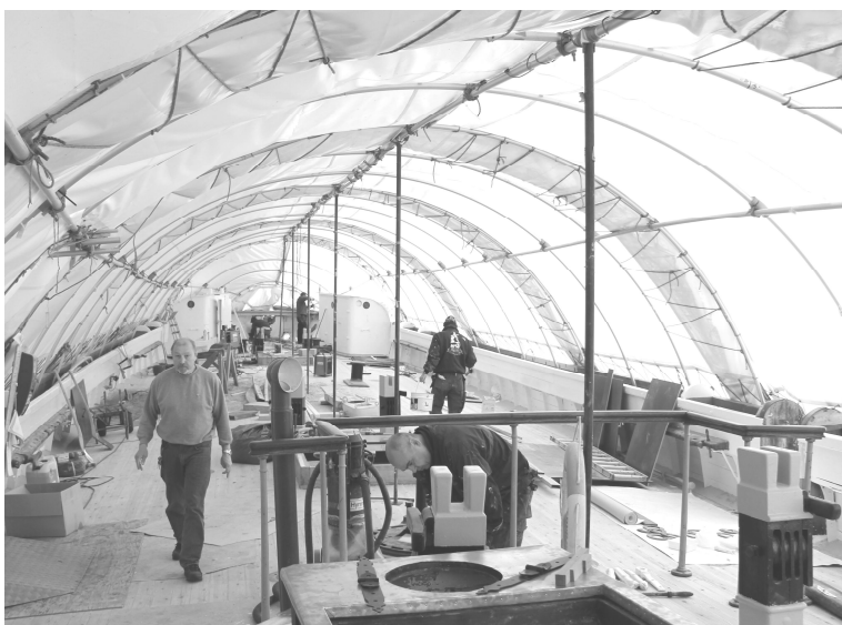
Träddäcket är nu lagt och ska hålla i 40 år framåt om man underhåller det.
